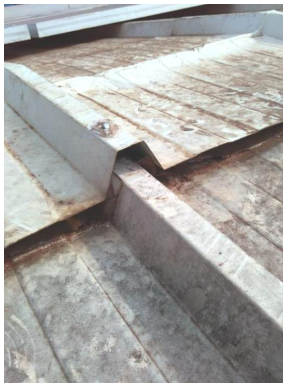
Figura 3 – Afastamento entre telhas adjacentes decorrente do trânsito contínuo diretamente sobre as mesmas
